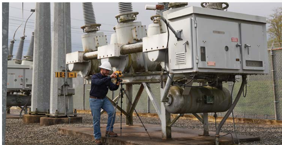
Un ispettore usa il rilevatore di gas Fluke Ti450 SF6 per ispezionare i collegamenti imbullonati.
